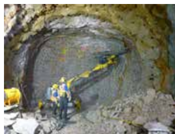
Brokk 180 utstyrt med boretårn.
